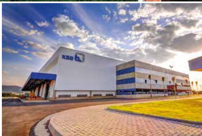
KSB Válvulas - Jundiaí/SP
